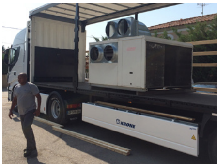
Opération de grutage et de manutention
