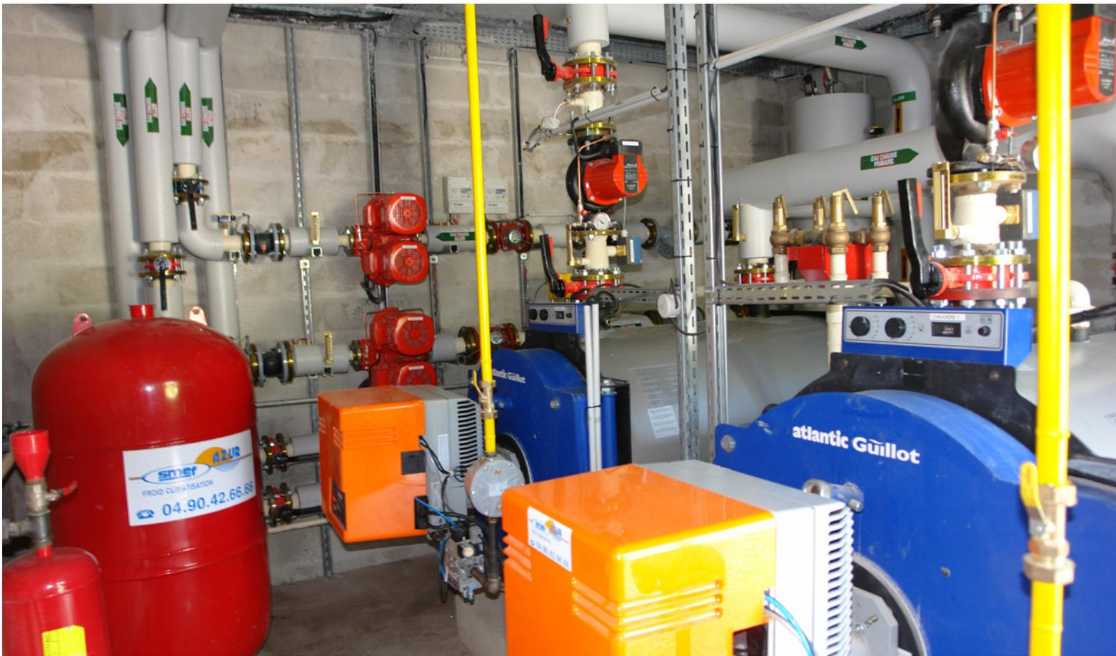
➔ Réalisation d'une chaufferie gaz d'une puissance de 700 kW, avec deux départs régulés alimentant les locaux d'activités des deux bâtiments.
