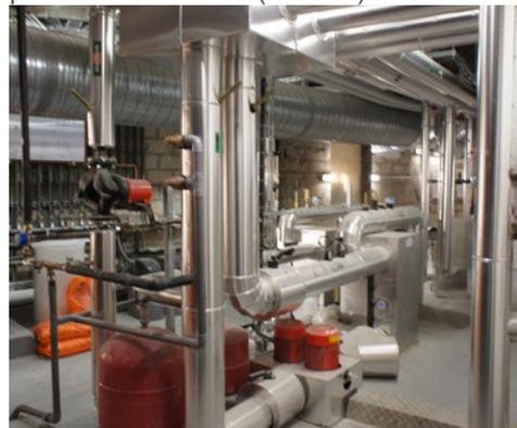
L'ensemble panoplie hydraulique, échangeur et réseaux secondaires de distribution d'énergie se situe également en local technique pour ensuite distribuer les différents terminaux
