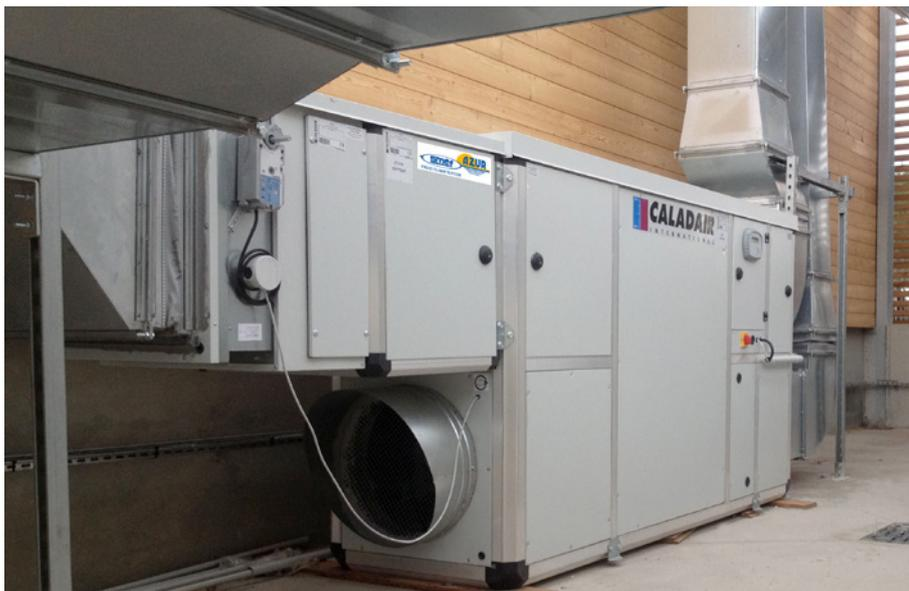
→ Trois centrales de traitement d'air de type double flux CALADAIR à récupération d'énergie sont implantées dans la cour de service. Elles assurent la ventilation de la surface de vente et des locaux sociaux.
