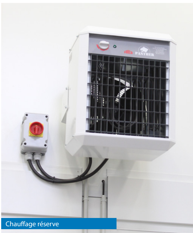
Chauffage des réserves sèches par aérotherme électrique
